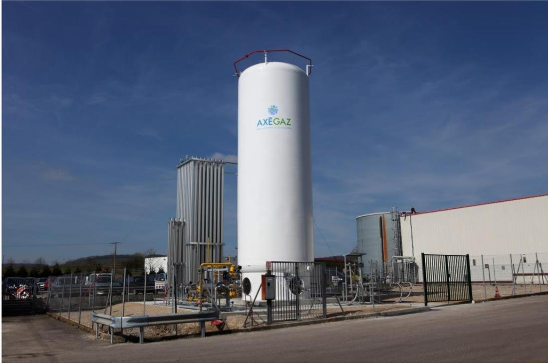
En février 2015, les travaux de génie civil pour créer notamment la dalle béton ont été lancés sous la maîtrise d'ouvrage de Duc. Une fois achevée, Axègaz a pris le relai et déployé ses expertises pour livrer le nouveau satellite GNL clé en main. En parallèle, Dalkia a adapté les brûleurs et injecteurs des chaudières ainsi que leur système d'alimentation.
